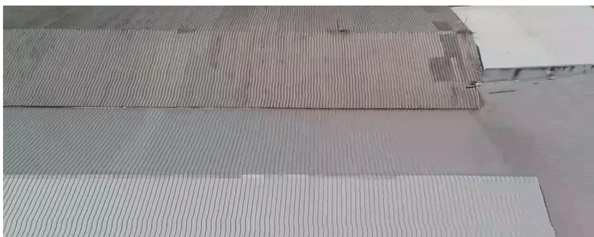
FOTO AÉREA SEC DE OBRAS
